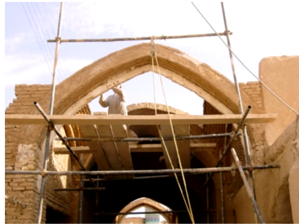
شکل (۲۱): چیدن شانه قوس با آجر (عکاس: محسن کشاورز).
