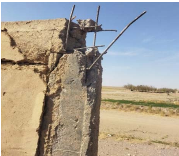
شکل (۲۰): نداشتن قلاب ۹۰ درجه میلگردهای تیر داخل ستون.
