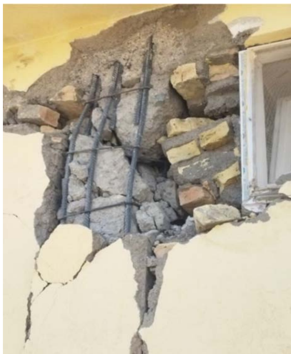
شکل (۱۷): عدم رعایت فاصله خاموت‌های ستون در ساحه زلزله زده.
