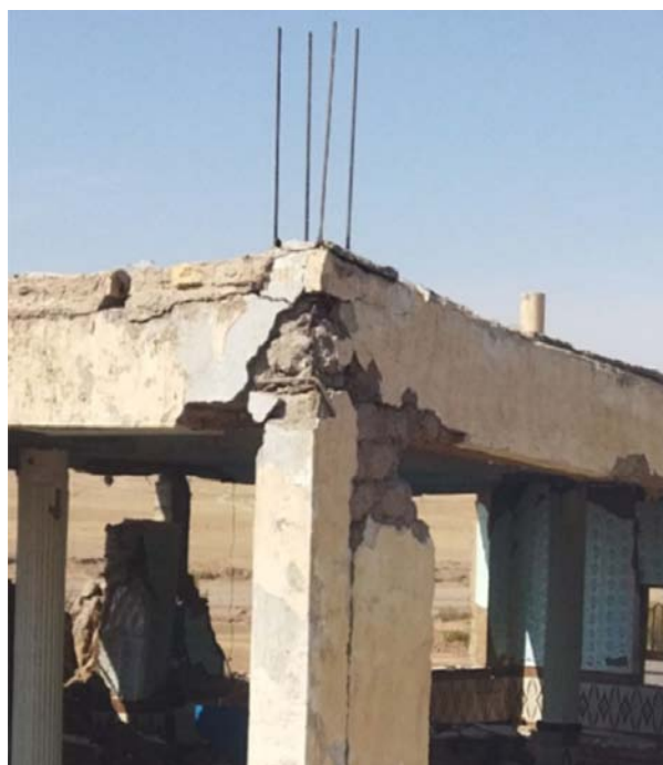
شکل (۲۴): نمونه از شکست فوق در ساختمان بتنی روستای کشکک.
