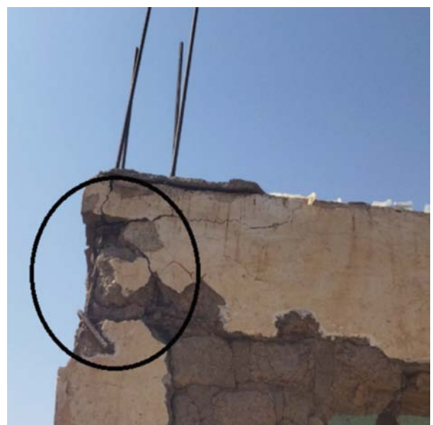
شکل (۲۲): رد کردن میلگردهای سراسری تیر از میلگردهای ستون.
