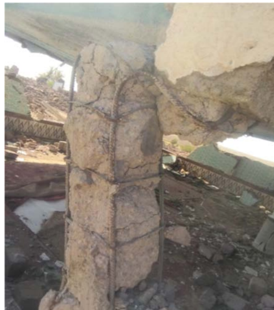
شکل (۱۸): عدم رعایت فاصله خاموت‌های در ستون در ساحه مورد مطالعه.
