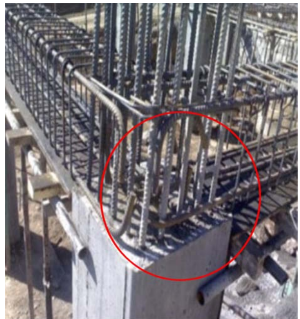
شکل (۲۱): رد کردن میلگردهای سراسری تیر از میلگردهای ستون.
