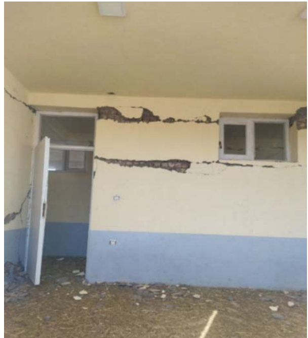
شکل (۳۱): فاصله ناکافی بین بازشو در و پنجره.
