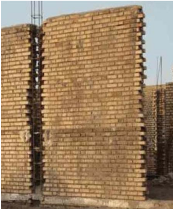
شکل (۲۵): کلاف قائم در دیوارهای محوطه.
