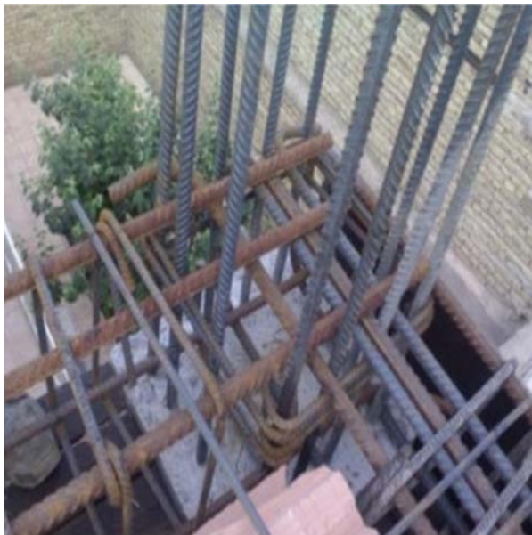
شکل (۱۹): نداشتن قلاب ۹۰ درجه.
