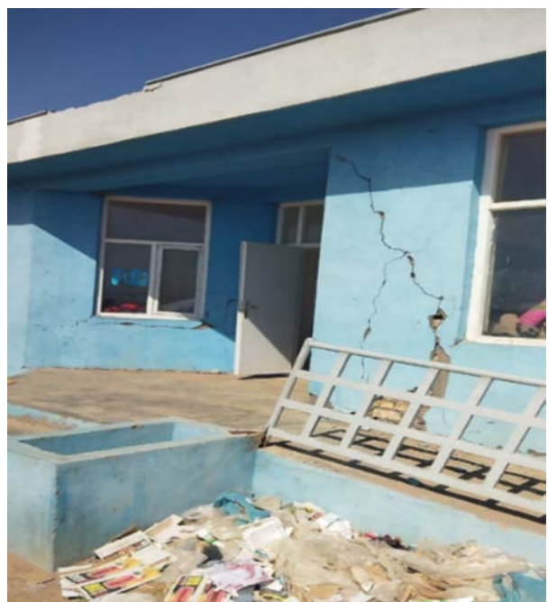
شکل (۳۲): عدم رعایت فاصله بازشو در و پنجره.
