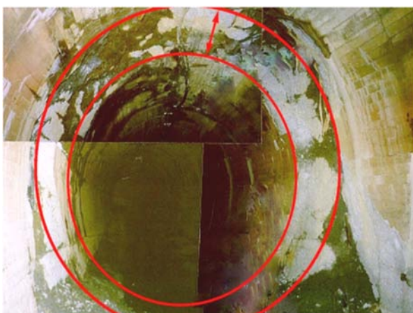
شکل (۳): خرابی ایجادشده در تونل شی گنگ در زلزله ۱۹۹۹ چی چی تایوان [۷]
