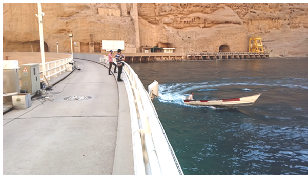
شکل (۶): مانور قایق در مخزن سد برای ایجاد ارتعاشات مصنوعی در بدنه سد، آرایه اول حس گرها.
