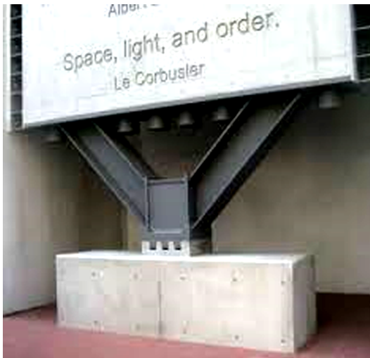
شکل (۲): دیوارهای برشی دارای حرکت گهواره‌ای در دانشگاه تی‌آی‌تی در پژوهش واد و همکاران [۱۲].
