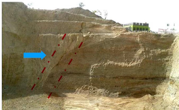
شکل (۲): نمونه‌ای از سازه در حال ساخت مستقر بر رخنمون گسل [۱۵].
