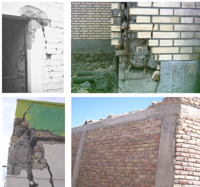
شکل (۴): چند نمونه از شکست کلاف قائم در اثر اندرکنش با دیوار [۱۳].
