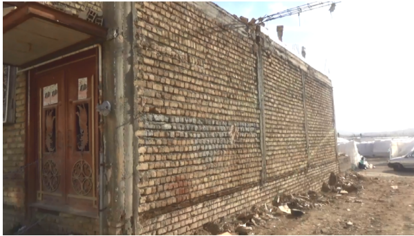
شکل (۱۵): ساختمان شماره پنج: ساختمان بنایی یک طبقه با کلاف افقی و قائم [۱۴].
