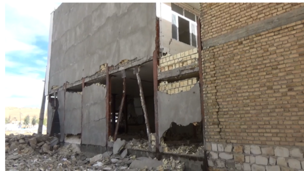
شکل (۸): عملکرد لرزه‌ای مطلوب‌تر ساختمان بنایی با کلاف افقی در مقایسه با ساختمان اسکلت فولادی مجاور با مهاربند برون‌محور [۱۴].
