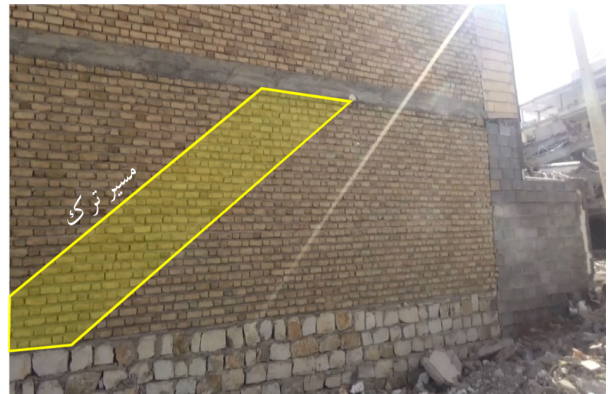
شکل (۱۹): ترک در ساختمان شماره یک؛ ساختمان بنایی دو طبقه با کلاف افقی.
