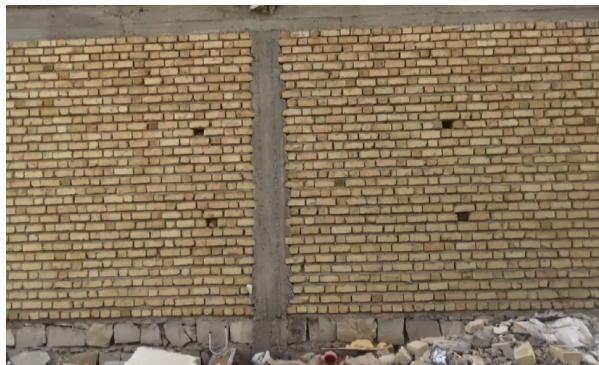
شکل (۱۰): کرسی چینی سنگی بدون کلاف افقی.
