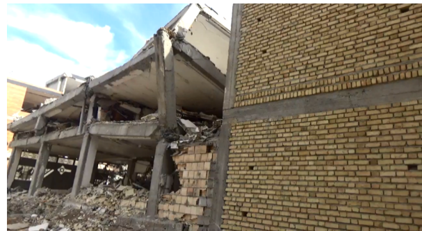
شکل (۱۱): عملکرد لرزه‌ای مطلوب‌تر ساختمان بنایی کلافدار در مقایسه با ساختمان اسکلت بتنی مجاور [۱۴].
