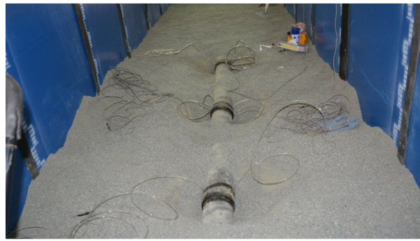
(ث) وضعیت لوله پس از نصب کرنش‌سنج‌ها و LPTها
