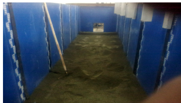
(ب) اجرای لایه اول خاک ریزی
