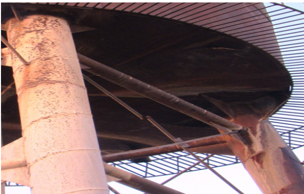
شکل (۵): کمانش بادبند.
