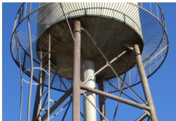
شکل (۶): کمانش بادبند.
