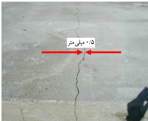
(ب) ترک منفرد عرضی سطحی به ضخامت ۰/۵ میلی متر
