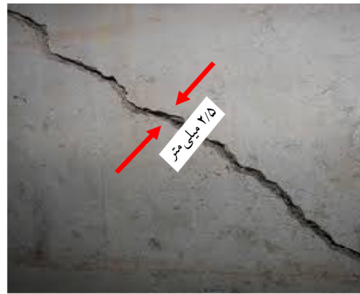
(الف) ترک منفرد عمیق قطری به ضخامت ۲/۵ میلی متر
