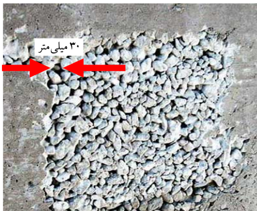
(ج) کرموشدگی متوسط با سوراخ‌هایی با عرض متوسط ۳۰ میلی متر
