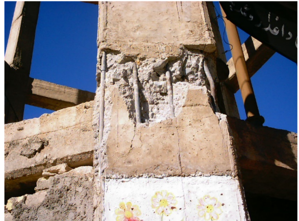
شکل (۲۱): خرابی پوشش ستون‌های بتنی در زلزله.
