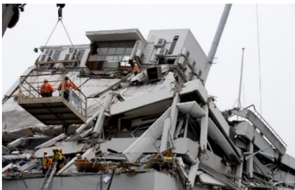
شکل (۲۷): شکست پنکیکی در زلزله اخیر ترکیه و کرایست چرچ نیوزلند.
