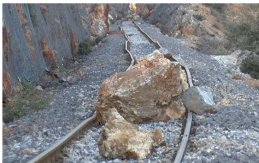
شکل (۳): خروج از خط قطار و ریزش‌های متعدد سنگ بر روی خطوط در اثر زلزله ترکیه در سال ۲۰۲۳.
