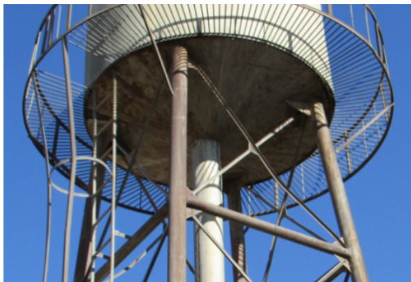
شکل (۶): کمانش بادبند.
