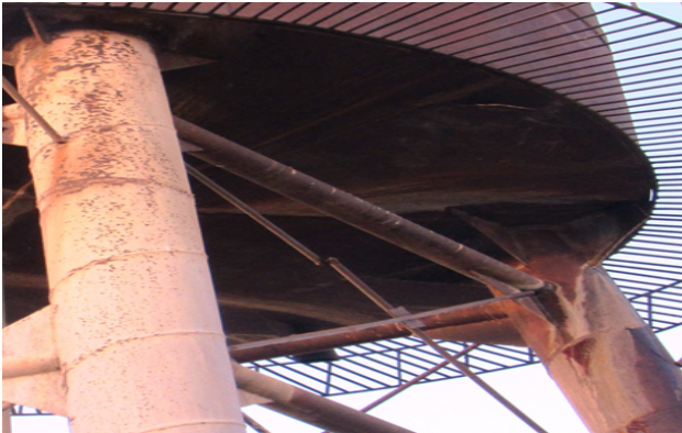
شکل (۵): کمانش بادبند.
