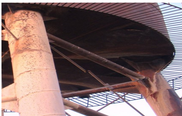
شکل (۵): کمانش بادبند.
