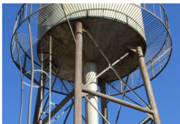
شکل (۶): کمانش بادبند.
